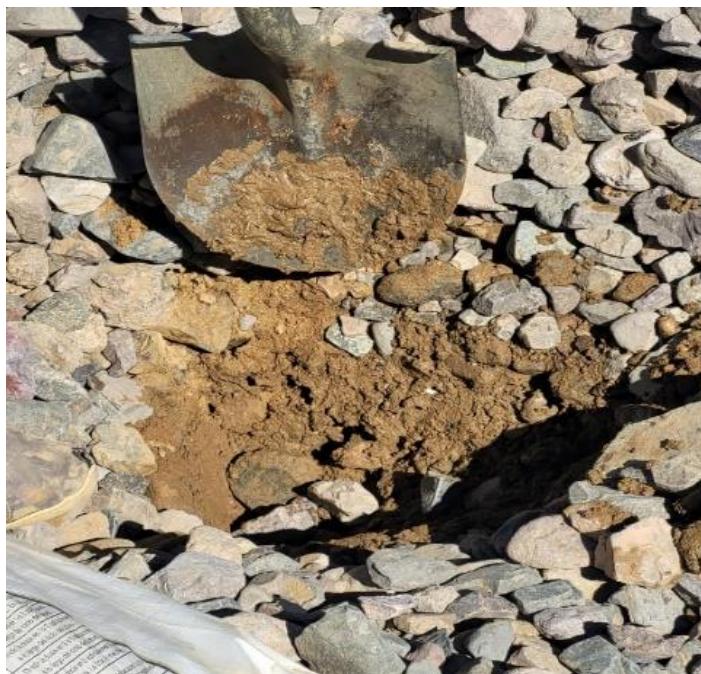
Revisión del dren de lixiviados
