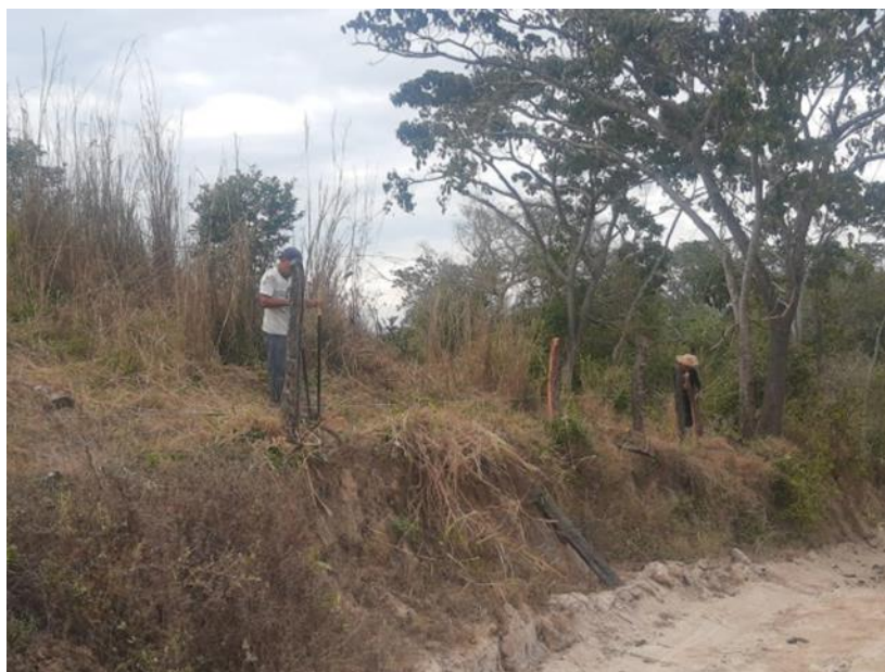
Instalación de cerco perimetral del predio con 4 hilos de alambre de Puas
