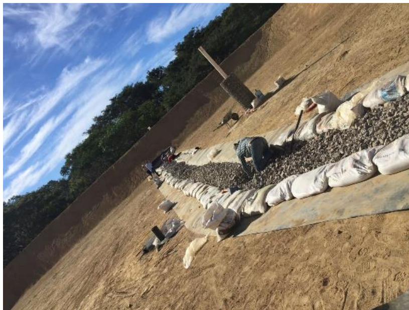
Revisión de grava que cubre el el dren de lixiviados.
