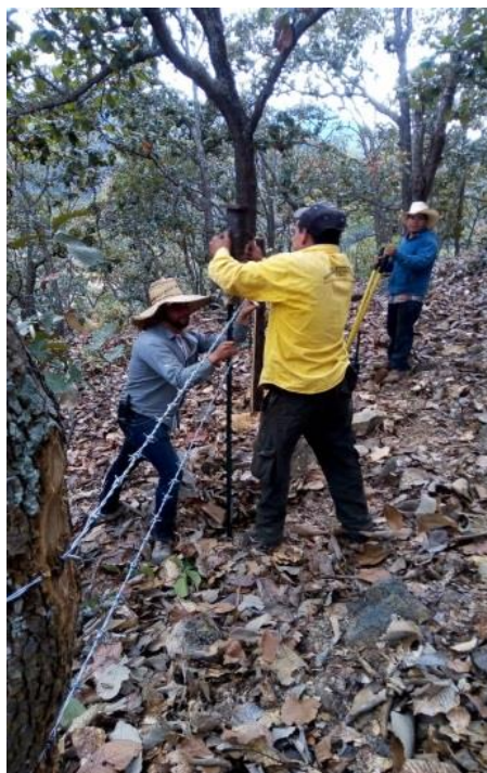
Cercado de la periferia del predio con cuatro hilos de alambre de púas y postes metálicos
