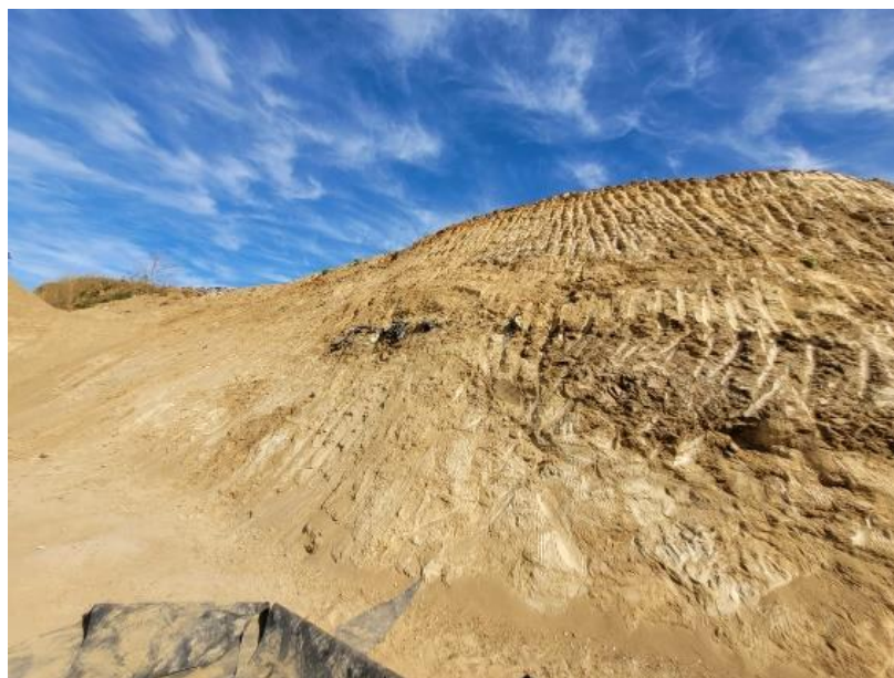
Talud con presencia de residuos
