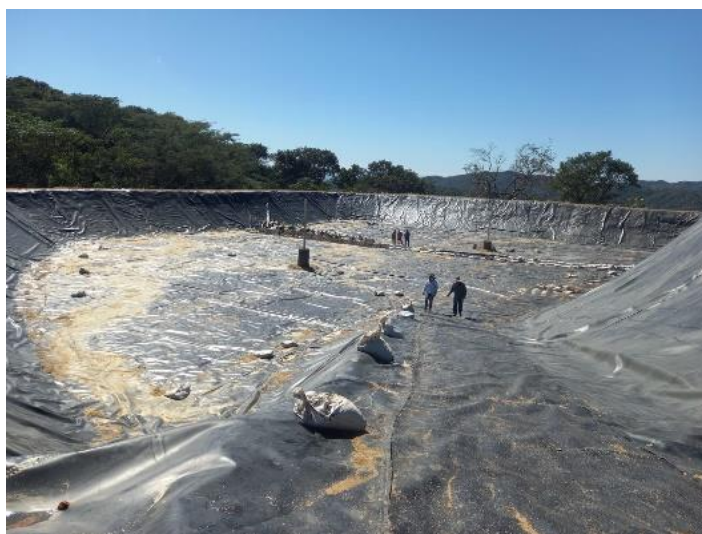
Revisión de instalación de geomembrana.
